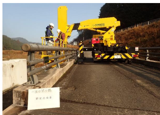
橋梁点検車による定期点検
