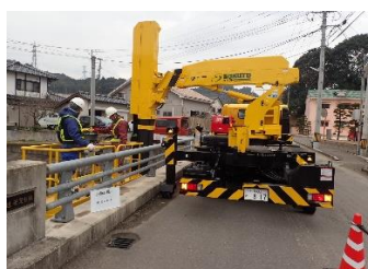
橋梁点検車による点検状況
