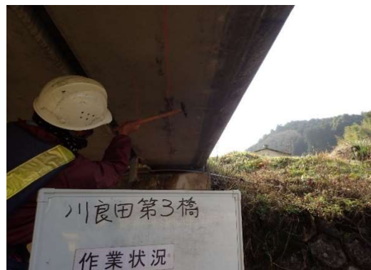
定期点検(打音検査)状況
