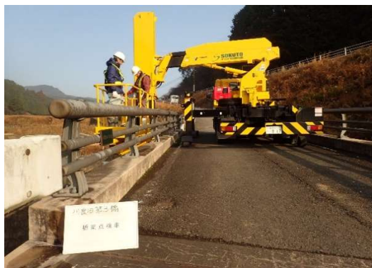
橋梁点検車による定期点検
