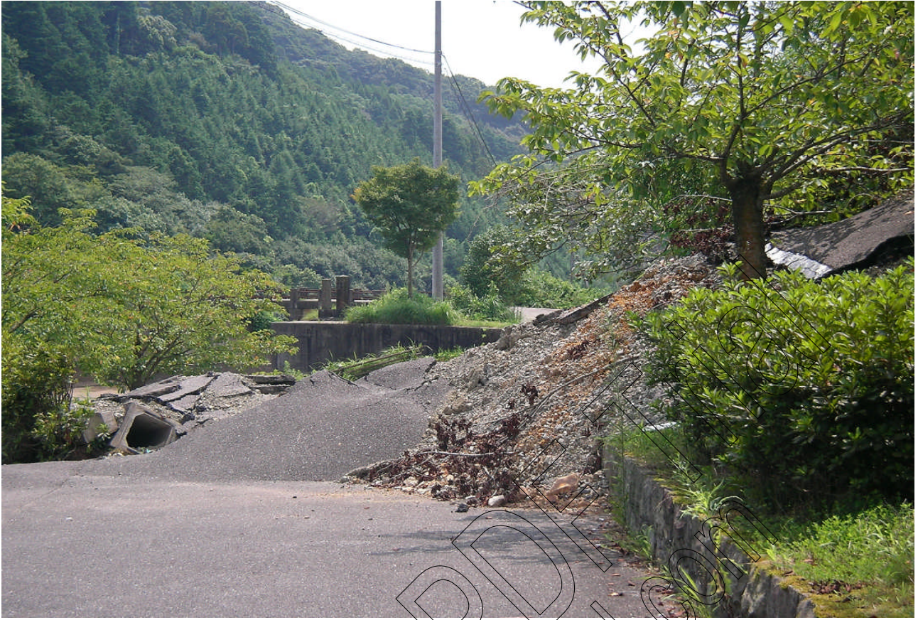
武内町側より撮影
