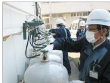
避難所に供給設備を設置 (埼玉県加須市)
