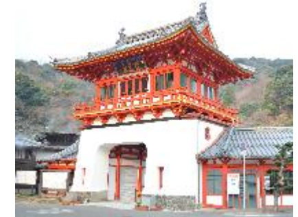
重要文化財の武雄温泉楼門
