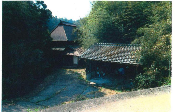
評価対象建物の北東側から撮影
