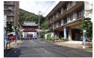
武雄温泉楼門
