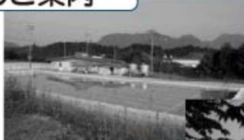
▲山内中央公園プール
