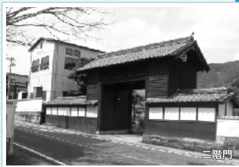
▲二階門は主屋の増改築と同時に新築され、両側の大きな家紋や通路の高い天井など独特のデザインになっています。
