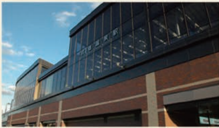
在来線高架完成
