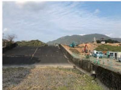
▲現在工事中の様子
