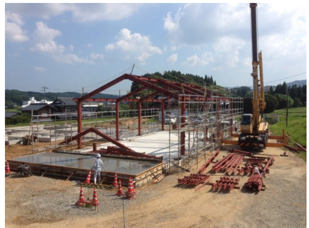
【建設中の武内公民館】
