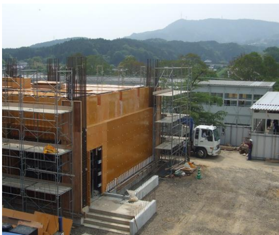
【山内中学校建設工事】
