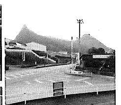
御船が丘小学校近くの三叉路交差点信号設置など道路改良工事中
