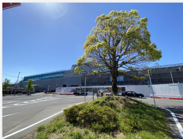
新幹線駅舎工事風景（駅南口広場より）
