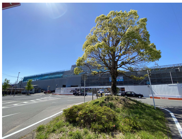
新幹線駅舎工事風景（駅南口広場より）
