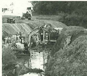
武雄川現在進む堰下流工事
