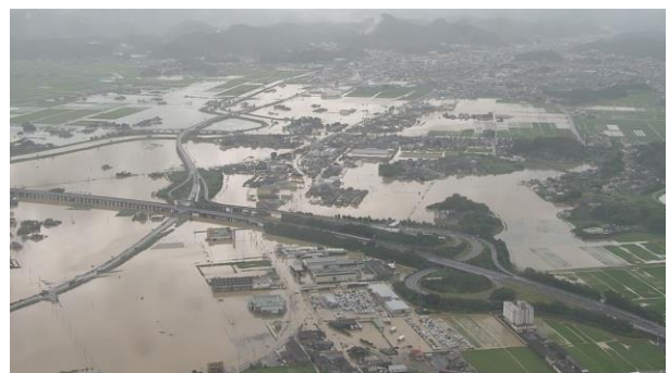
▲令和元年8月集中豪雨による被害の様子 （提供:国土交通省九州地方整備局武雄河川事務所）
