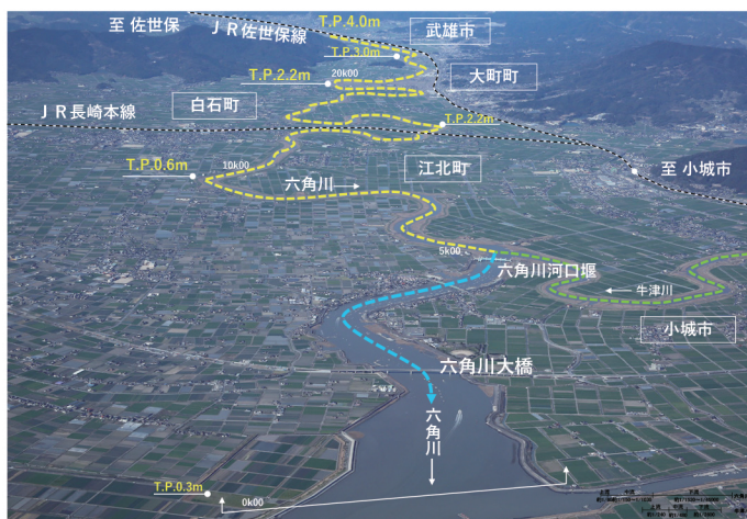
▲六角川流域は、約4割が山地、約6割が低平地
