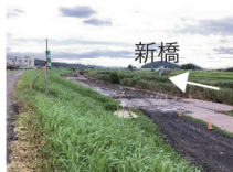
▲ヨシ伐採後 湛水池の整備中
