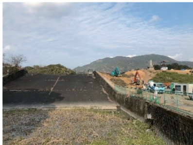
▲現在工事中の様子
