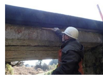
石橋の点検状況
