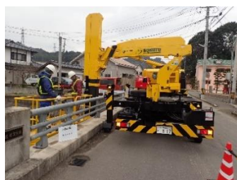
橋梁点検車による点検状況
