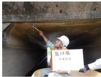
ボートによる点検状況
