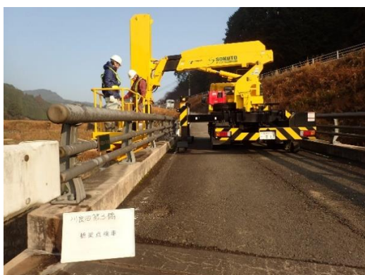
橋梁点検車による定期点検
