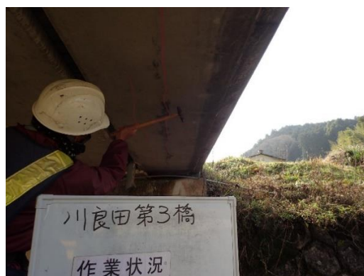
定期点検(打音検査)状況
