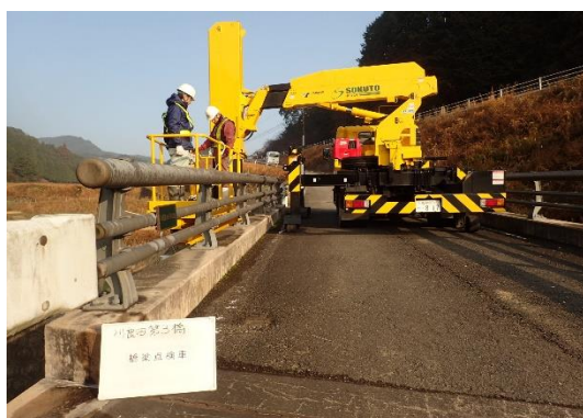
橋梁点検車による定期点検
