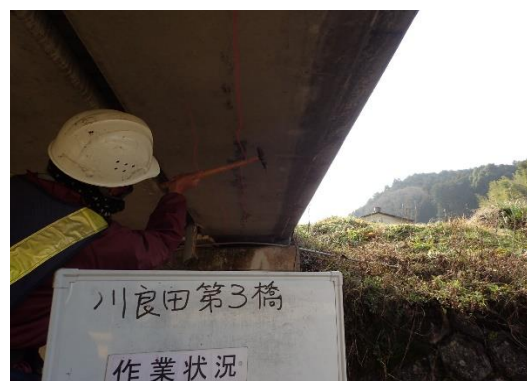
定期点検(打音検査)状況
