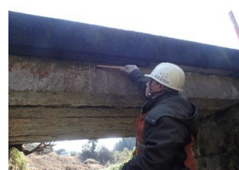
石橋の点検状況
