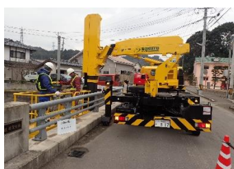
橋梁点検車による点検状況
