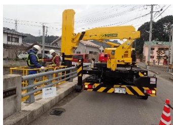
橋梁点検車による点検状況
