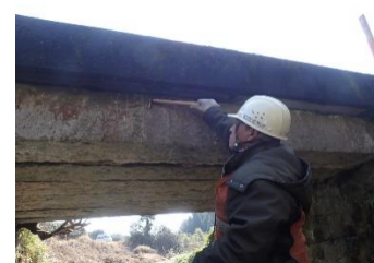
石橋の点検状況
