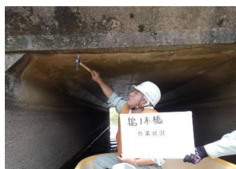
ボートによる点検状況
