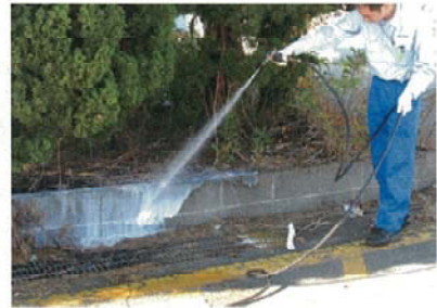
専門業者による液剤の高圧散布
