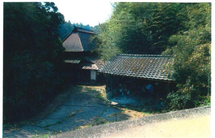
評価対象建物の北東側から撮影
