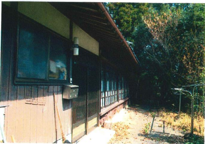
評価対象建物（主である建物）の南西側から撮影
