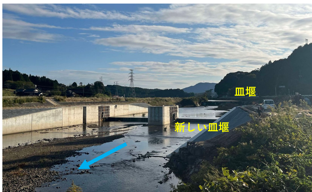
写真 3-2-1 堰改築の整備状況(令和6年時点)
