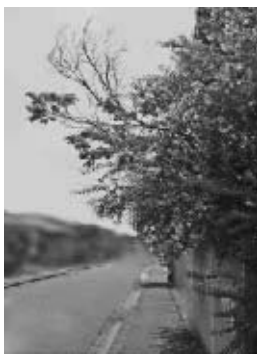
枝が道路に出て通行の際、とても危険です。
