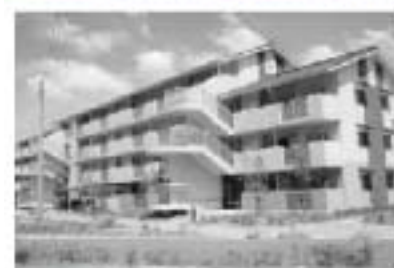
久保田住宅の外観
