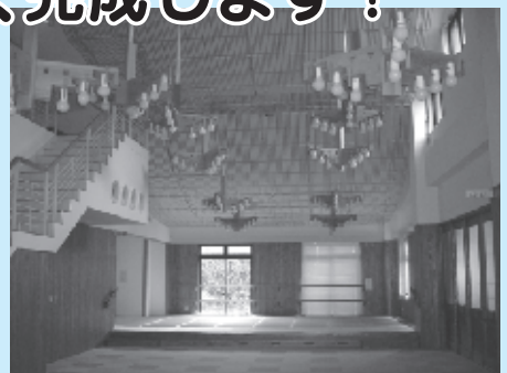
▲改修した多目的スペース
