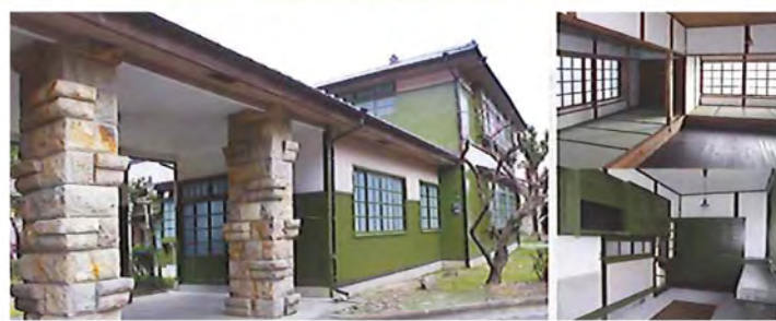
修復された寄宿舎
