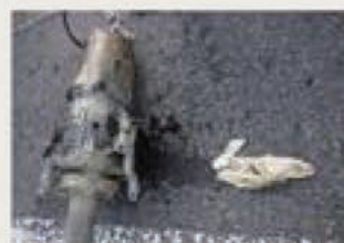
▲下水道ポンプに詰まった布
