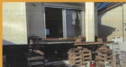
▲かさ上げ工事
