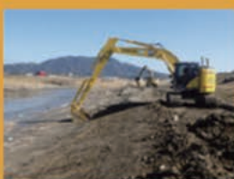
六角川水系掘削工事
