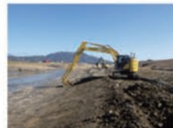
河道掘削工事
