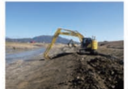
河道掘削工事
