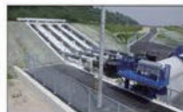
整備中 広田川排水機場の
