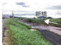
▲ヨシ伐採後 湛水池の整備中
