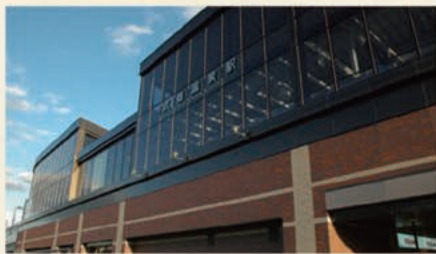
在来線高架完成
