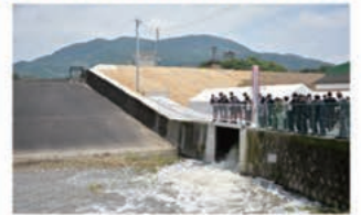
▲山口県知事の合図で、ゲートが開いた。平均2.3 m 3 /sが排水される。
