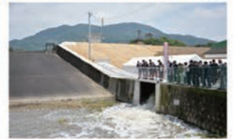
▲山口県知事の合図で、ゲートが開いた。平均2.3 m 3 /sが排水される。
