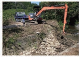
▲河川に流れた土砂の除去
