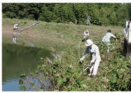
▲堤体の草刈り
