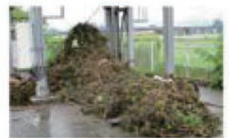
▲除塵機で取り除かれた塵芥（ゴミ） 農業用のシートやパレットなどが 流れ着く場合もあります。
