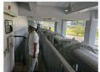
▲除塵機の点検
