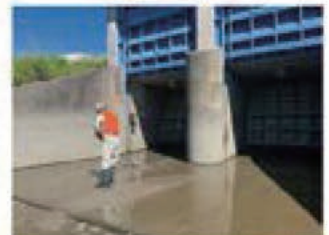
▲樋門の点検・周辺の清掃
