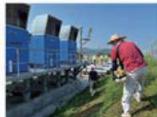
▲施設内の草刈り
