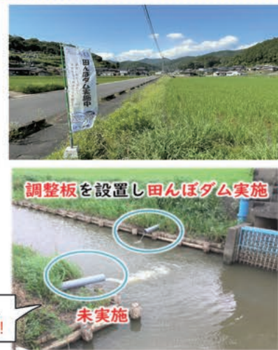
田んぼがダムの役割をすることで、大雨時に水路へ流出する水を抑制！
