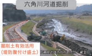
六角川河道掘削
