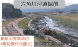
六角川河道掘削
