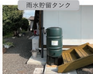
雨水貯留タンク
