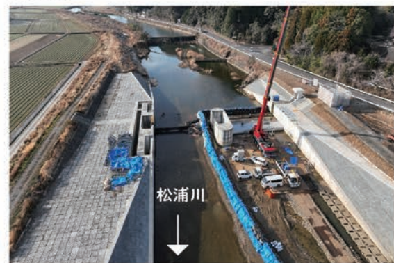
▲ 血堰の改修状況
