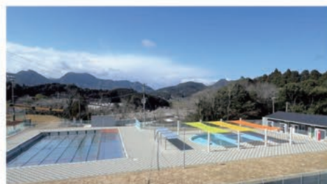
▲プールの全景
