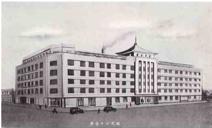
奉天ビル全景
