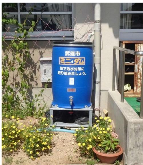
写真 3-2-2 雨水貯留タンク
