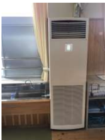
北方小学校 仮設エアコン設置
